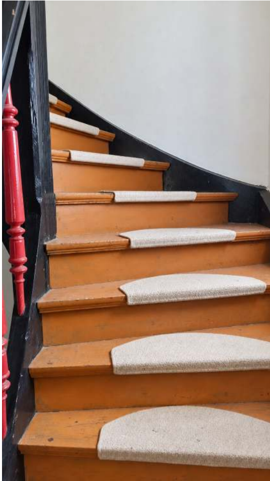
Treppenaufgang mit farbig gefasstem Geländer
