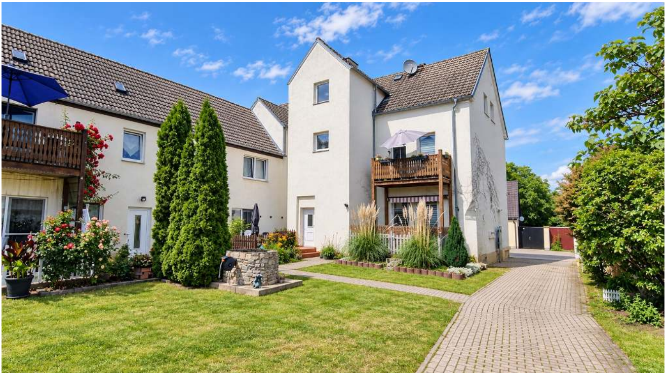
Rückwärtige Wohngebäude mit befestigter Zufahrt
