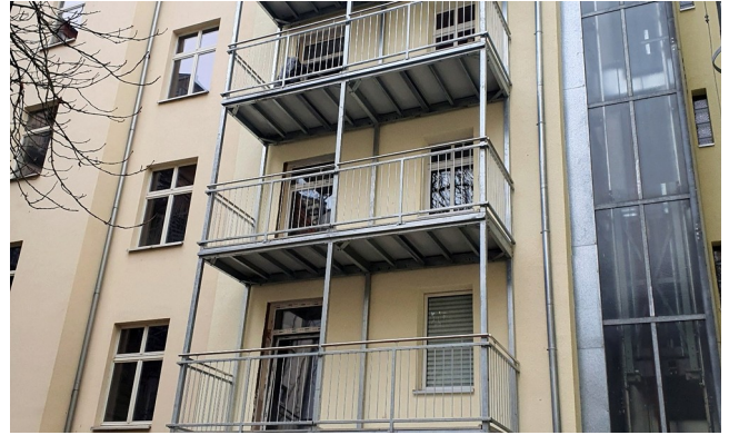
Rückfassade aus dem Innenhof
