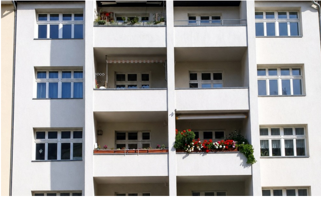
Vorderfassade des Wohn- und Geschäftshauses
